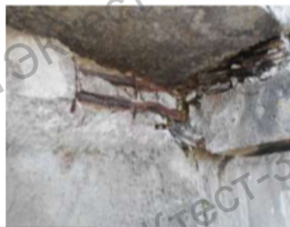
полное разрушение бетонной балки и утрата несущей способности
