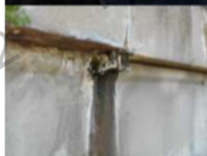
полное разрушение бетонной балки и утрата несущей способности
